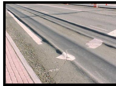
Rodera por una pobre mezcla que produce inestabilidad
