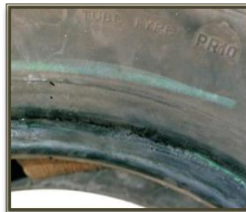
Deterioro en la zona de apoyo
