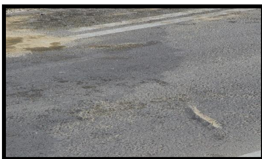
Hendidura marcando el PC del accidente
