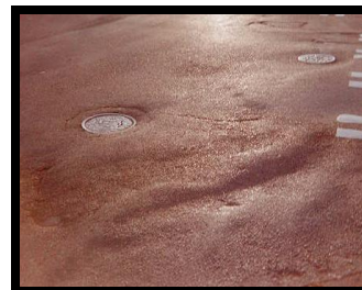
Pliegues y deslizamientos de la capa de rodadura del firme
