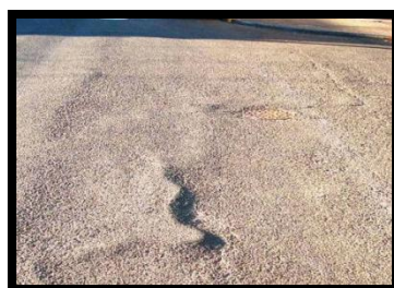
Pliegues y deslizamientos de la capa de rodadura del firme
